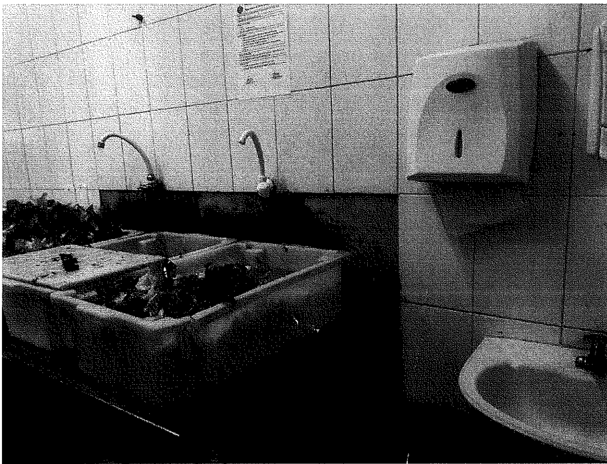
Figura 6 - Área com presença de mofo próximo ao preparo de verduras. Fonte: Autoria própria.
